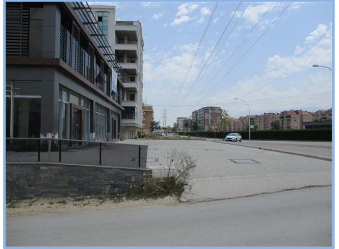
Ön Cephe ve Açık Otopark Alanı
