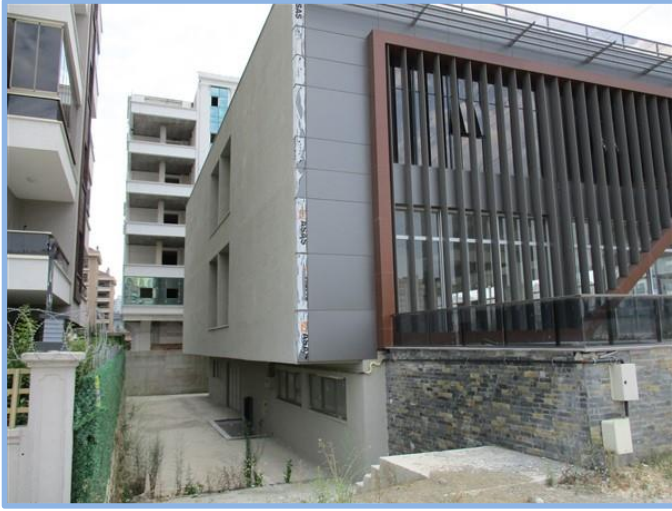
Arka ve Sol Yan Cephe
