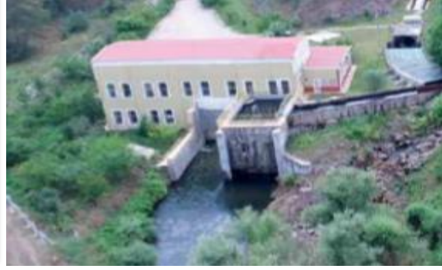
ÇAYGÖREN HES 4,60 MW
