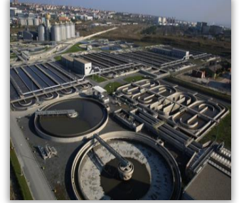
Ambarlı Atık Su Tesis
