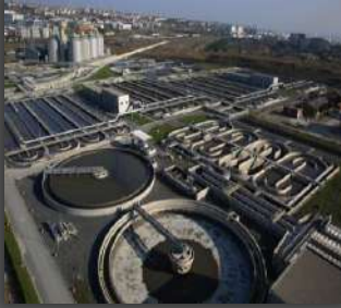
Ambarlı Atık Su Tesis
