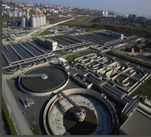
Ambarlı Atık Su Tesis
