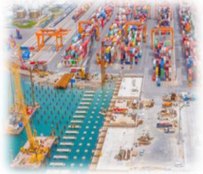
İnşaat & Kazık Boruları
