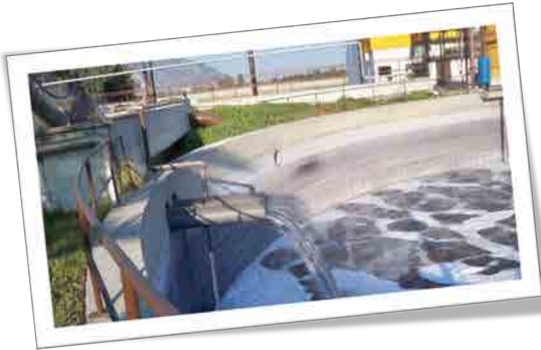
Söktaş Tekstil Atık Su Arıtma Tesisi
