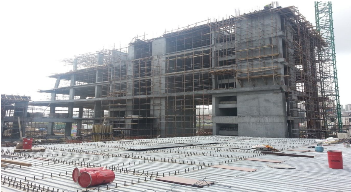
Otel inşaatı ilerleme durumu (Şubat 2013)
