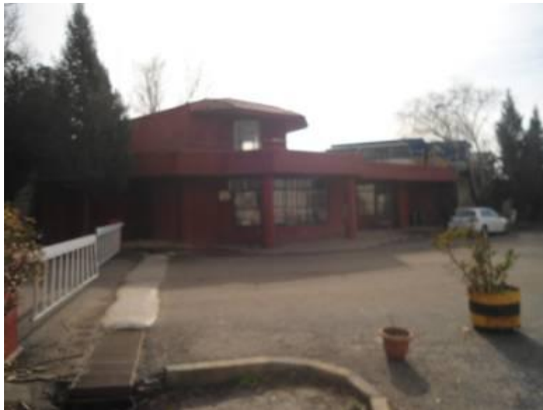
Güvenlik ve Personel giriş Binası
