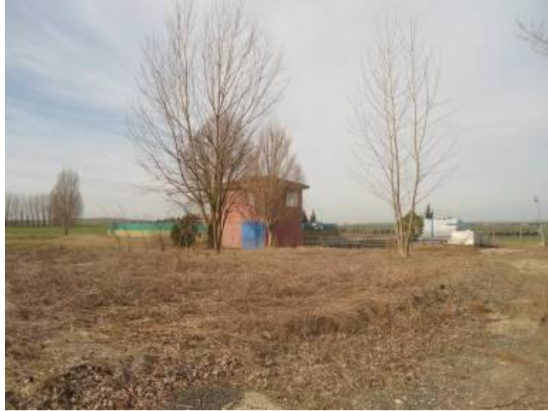
Arıtma Tesisi ve kontrol binası
