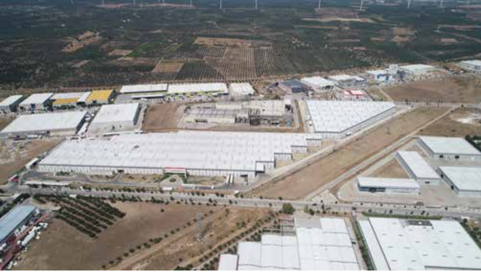
Radyatör Tesisi Görünümü
