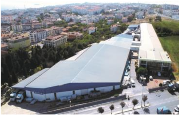
Beylikdüzü Boru Fabrikası
