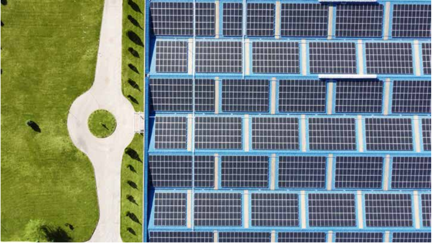
Elazığ Boru Fabrikası
