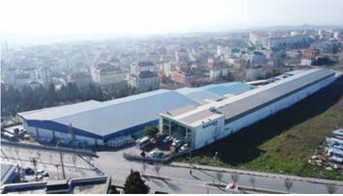
Beylikdüzü Boru Fabrikası
