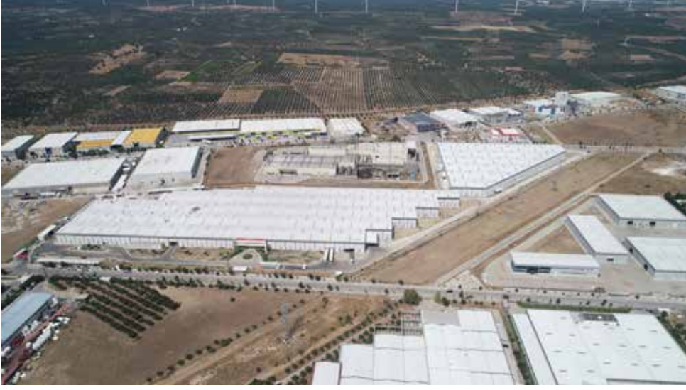
Radyatör Tesisi Görünümü
