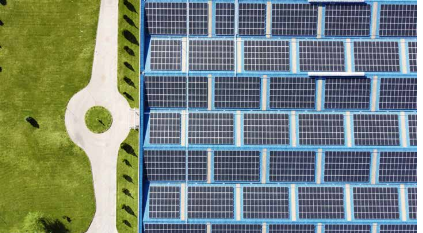
Elazığ Boru Fabrikası
