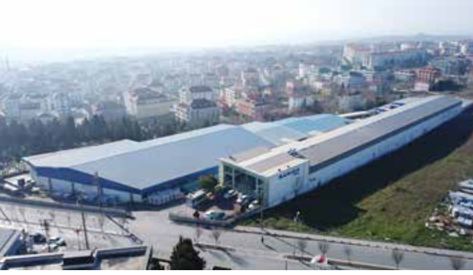
Beylikdüzü Boru Fabrikası
