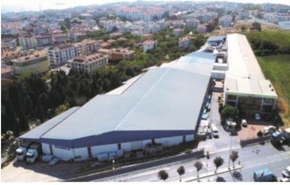
Beylikdüzü Boru Fabrikası
