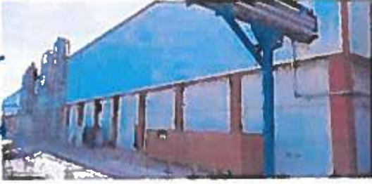
TM 1 ve TM 2 Binası
