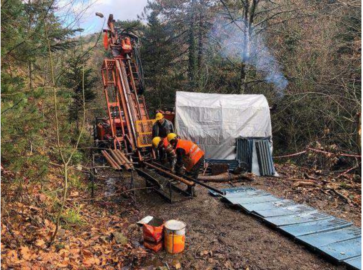
Foto 12: Spiral Ocak Bölgesi Sondaj Çalışması
