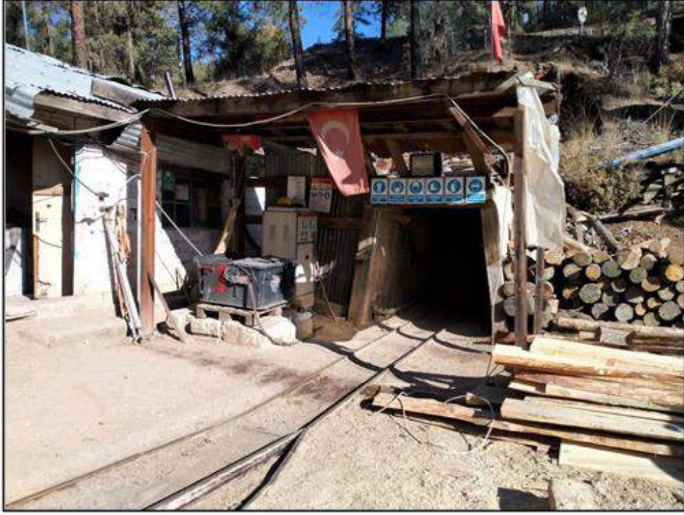
Foto 3: Hudut-3 Yeraltı İşletmesi Girişi
