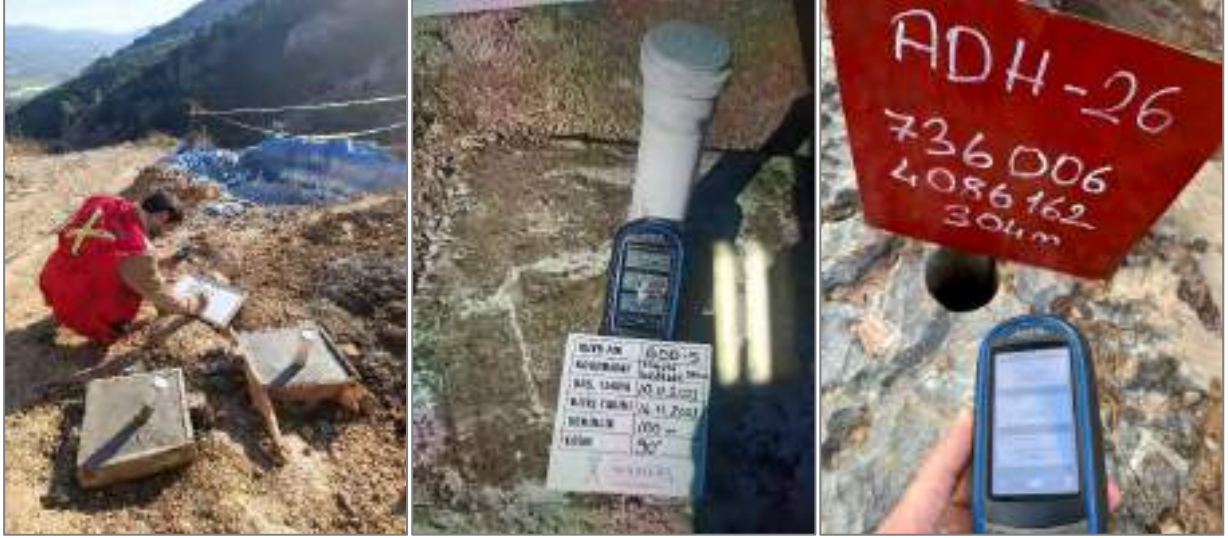
Şekil 72 Kuyu başı betonu, levhası ve etiketlemeleri.
