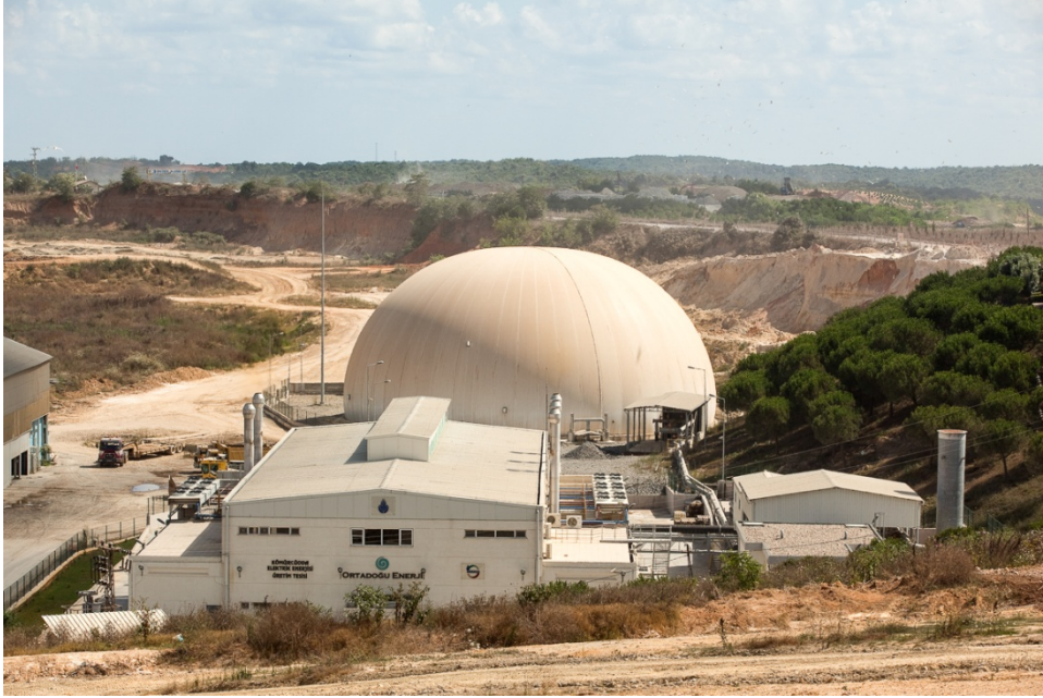
Şekil 4.7 Kömürcüoda Tesis Gaz Depolama Balonu
