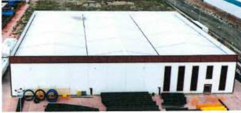
Koroze Boru Üretim Tesisi
