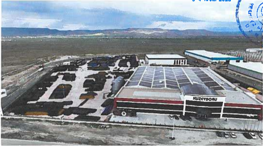
Resim 1: Kuzey Boru Merkez Fabrika Binası
