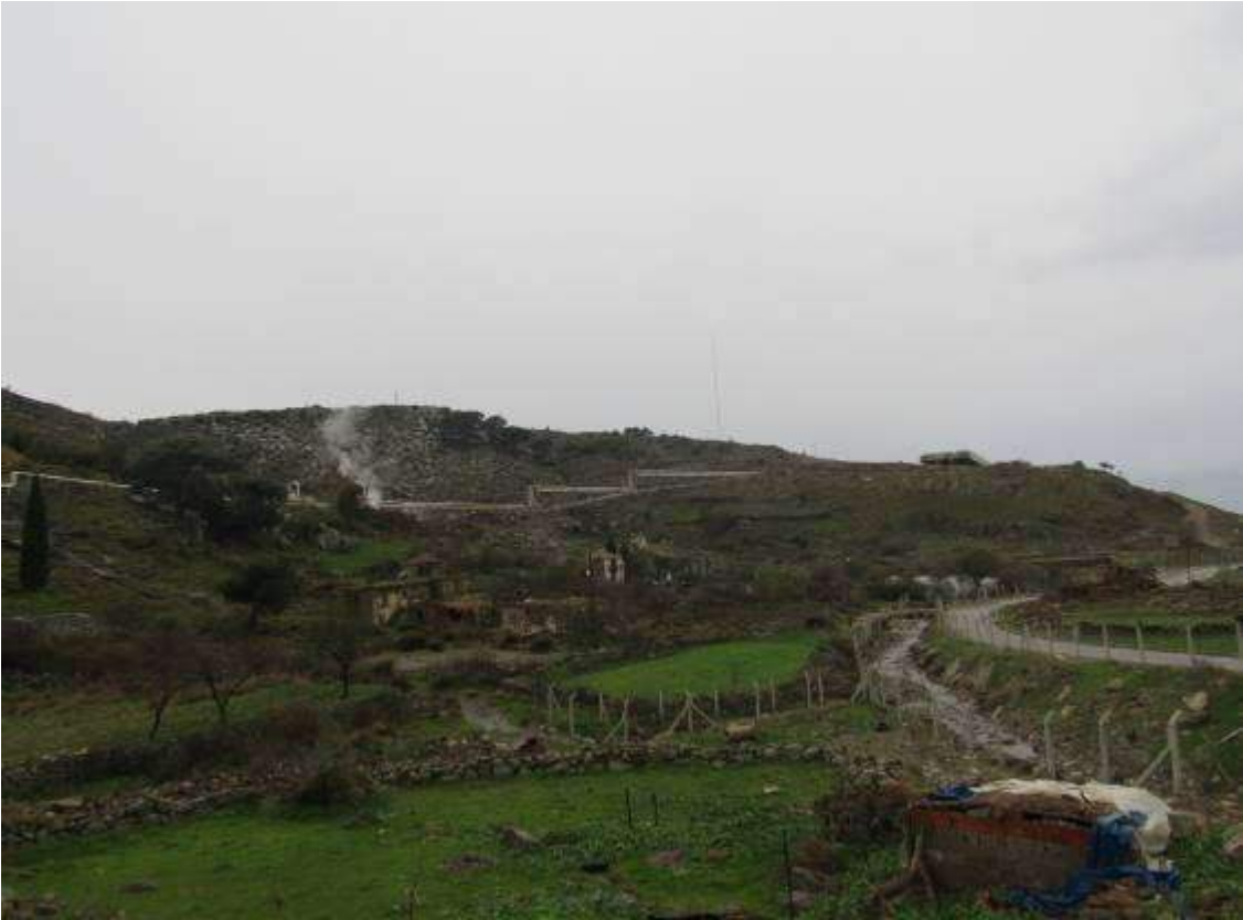
Tesisin Görünümleri Türbin ve Jeneratör Üniteleri
