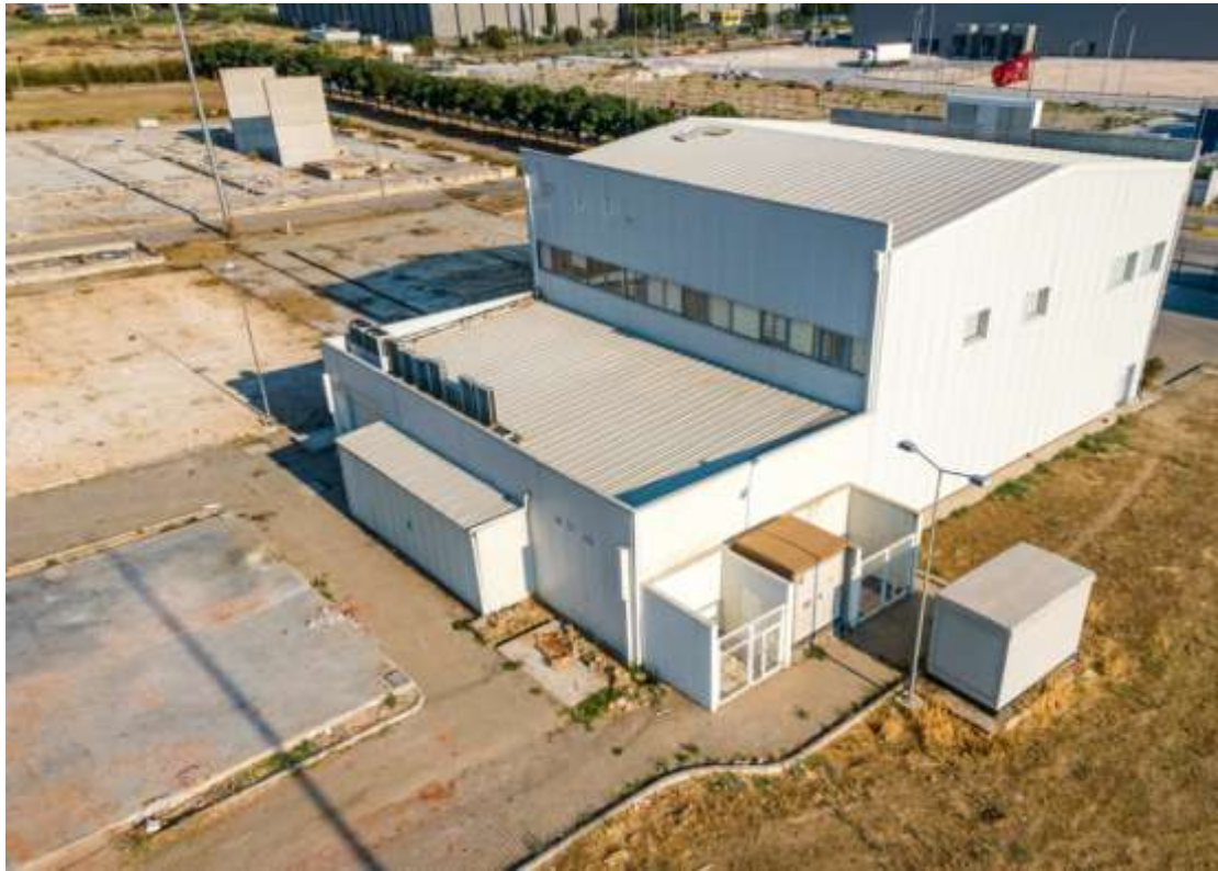
Taşınmazın Görünümleri (İdari bina)
